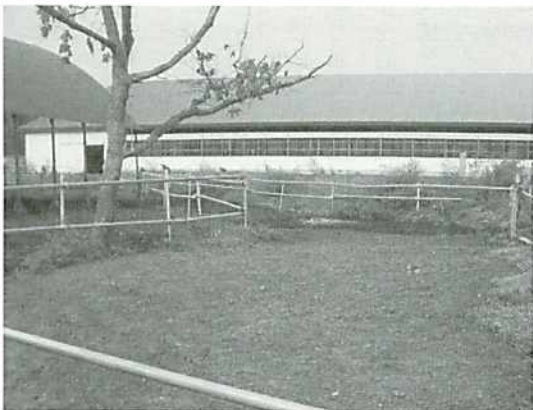
施工予定地の整地(汚泥・糞尿の除去)
